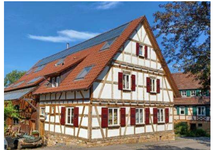
Beispielfoto einer erfolgreich abgeschlossenen Modernisierungsmaßnahme
