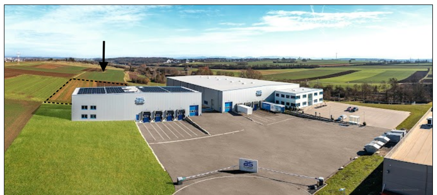
Abb. 3.1-3: Ansicht aus Westen auf das bestehende Betriebsgelände der Firma as - Schwabe GmbH (Quelle: www.as-schwabe.de ) mit der gepl. Erweiterungsfläche (Pfeil)
