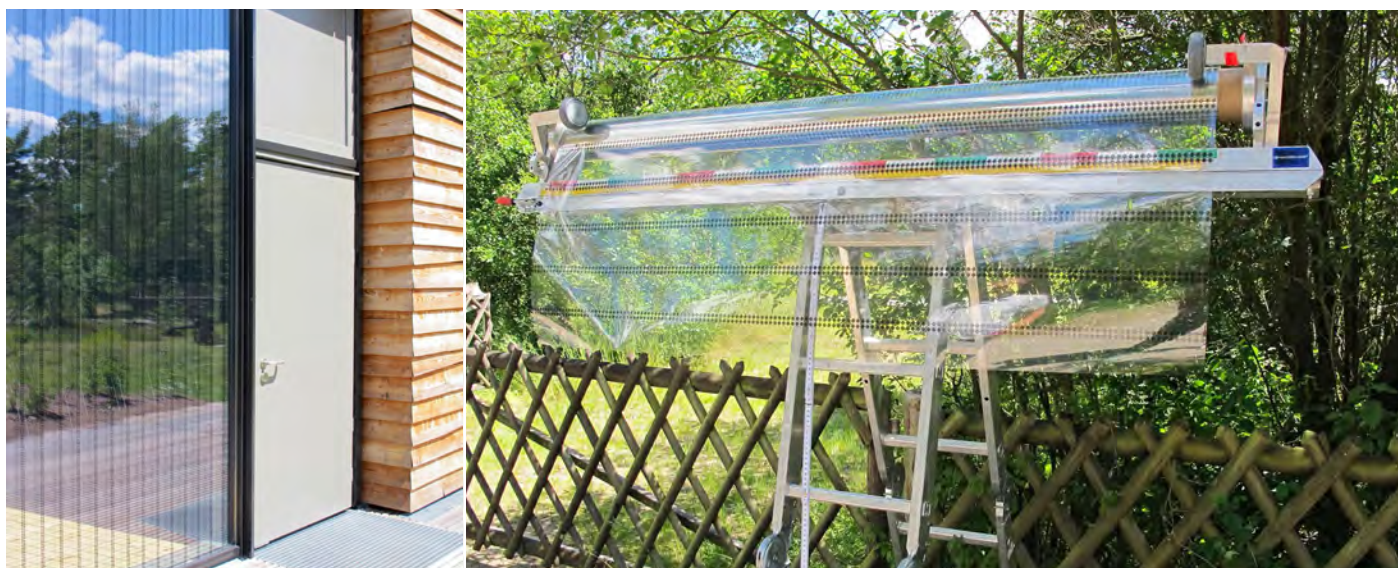
Bedruckte Folien werden vollflächig aufs Glas aufgebracht.
