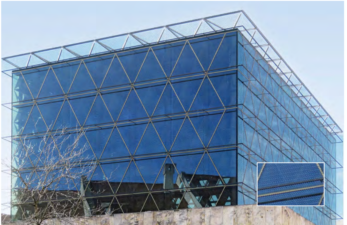
Der Glaskubus des Jüdischen Zentrums von Wandel Hoefer Lorch + Hirsch in München ist umgeben von einer stählernen Stützkonstruktion und einem Bronzegewebe. Ein Dreiecksmuster aus Davidsternen sorgt durch das Spiel von Licht und Schatten im Gebetsraum für eine besondere Atmosphäre.
