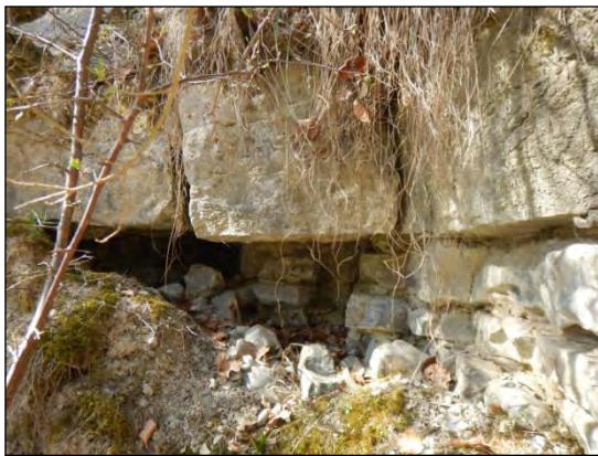
Zugeschütteter Eingang an Steilwand
