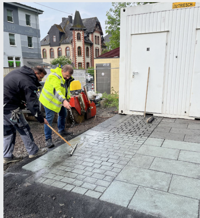
Herstellung einer Musterfläche
