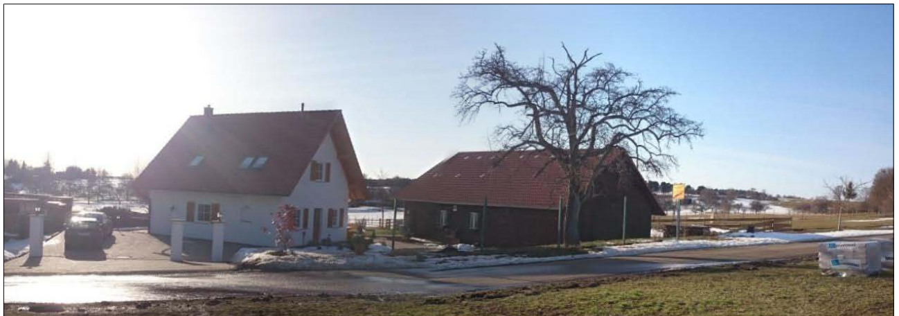
Abbildung 7: Blick auf das Wohnhaus und Nebengebäude aus Richtung Osten
