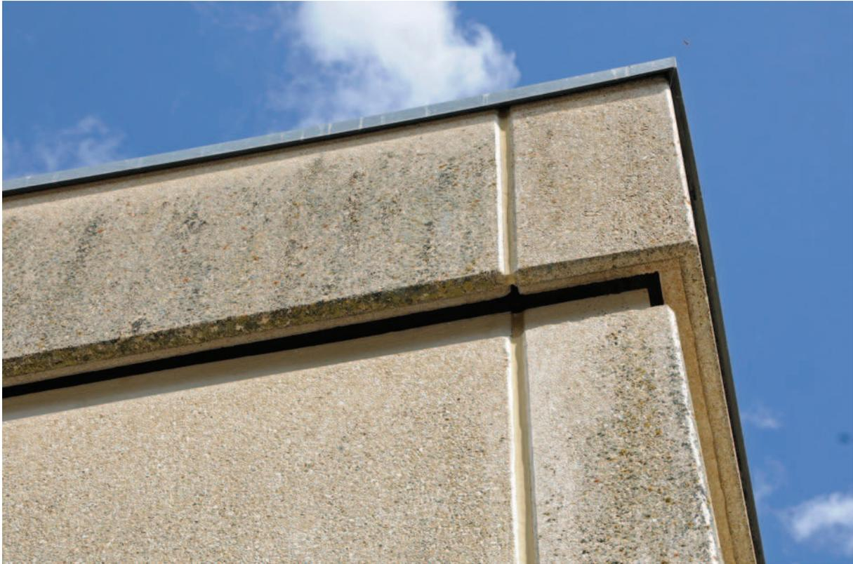
**Abbildung 6:** Detail der Dachhinterlüftung an der Sporthalle.
