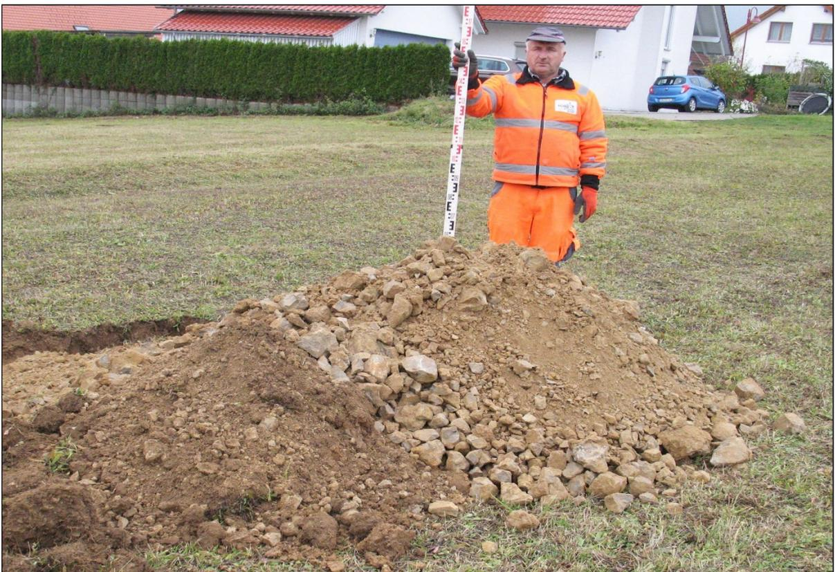
Foto 2: Aushub Schurf S 2: Steinige-kalksandige Böden (Schurftiefe ca. 2,6 m)
