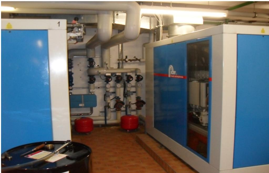
BHKW-Anlage in der Kläranlage Horb mit zwei Gasmotoren, mit einer elektrischen Gesamtleistung von 88 kW. Die dabei anfallende Wärme wird zum Faulturn- und Gebäudeheizen verwendet.
