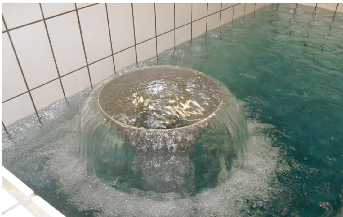
Mischwasserkammer mit 150 m<sup>3</sup> Fassungsvermögen im Hochbehälter Rufäcker. Hier wird eigenes Wasser mit dem der Kleinen Kinzig gemischt
