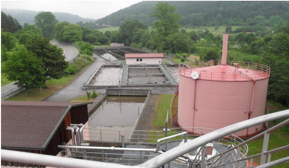
Sicht vom Schlammfahlfbehälter auf den hinteren Teil der Kläranlage mit Gasbehälter, Vorklärbecken, Anaerobes Becken, vorgeschaltetem Denitrifikationsbecken, Nitrifikationsbecken sowie den Nachklärbecken
